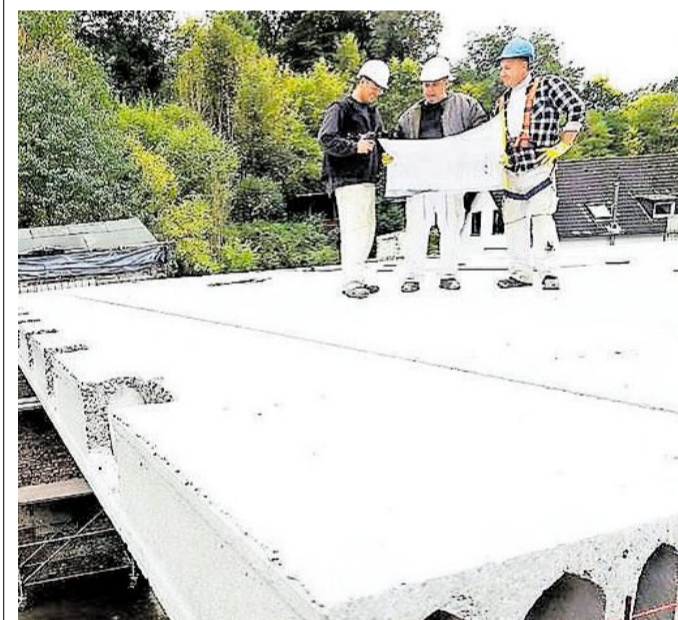
Das Dach schließt sich: Stück für Stück werden die bis zu 14 Meter langen Betonplatten auf den Ringanker der Hallenmauern gelegt. Foto: D. Siewert
